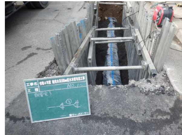
令和4年度 朝見水系500mm配水本管布設工事
