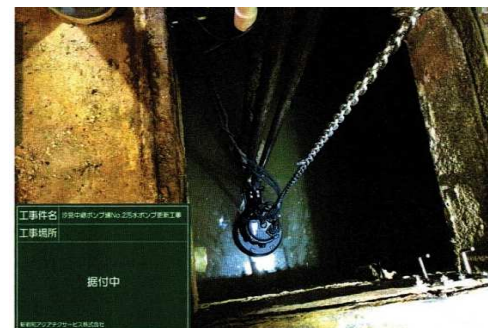
汐見中継ポンプ場No.2汚 水ポンプ更新工事
