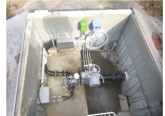
タタラ水源地2号取水ポンプ取替工事
