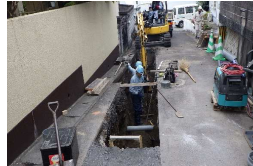
荘園1号汚水幹線管きよ 布設工事
