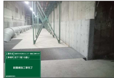
管理棟耐震補強工事
