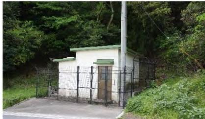
明砦送水ポンプ 送水能力：280m<sup>3</sup>/日【平成16(2004)年3月築造】
