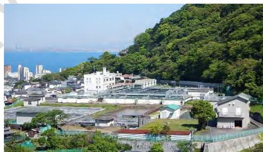
朝見浄水場 浄水能力：58,000m<sup>3</sup>/日【昭和44(1969)年6月築造】
