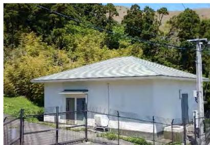
湯山送水ポンプ 送水能力：1,170m<sup>3</sup>/日【平成11(1999)年3月築造】
