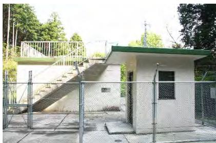
西鉄輸配水池 有効容量：100m<sup>3</sup>【平成23(2011)年4月築造】
