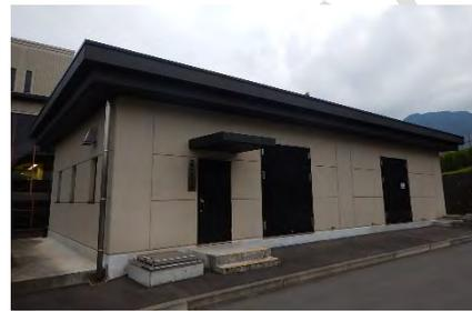
西野口送水ポンプ 送水能力：10,000m<sup>3</sup>/日【平成27(2015)年3月築造】
