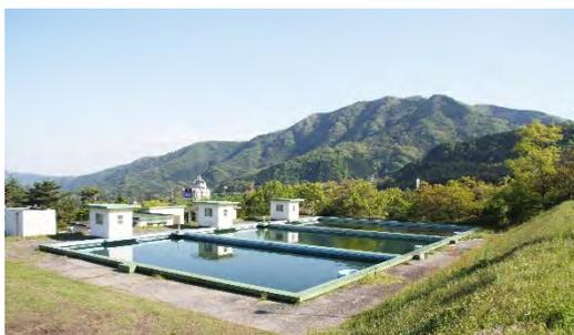
扇山浄水場 浄水能力：5,040m<sup>3</sup>/日【昭和43(1968)年9月築造】
