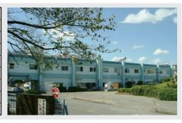
し尿処理場「春木苑」は、市内全域の下水道を除く生し尿及び浄化槽汚泥の処理を目的に昭和44年に設置されています。平成17年度に施設の精密機能検査を実施したところ、消化槽及び曝気槽は15年程度の耐用年数が残っていることが判明したため、平成19年度に管理棟の耐震補強と外壁改修工事をし、平成20年度に曝気槽の内部改修工事を行い施設の長寿命化を図っています。
