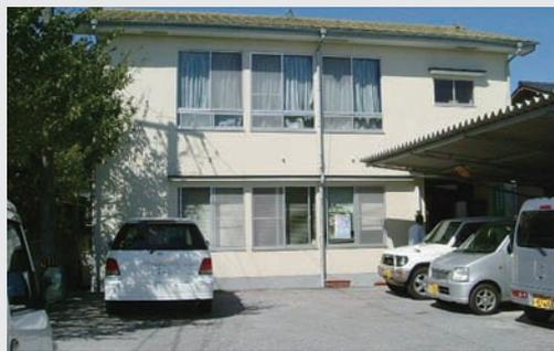
勤労者研修センターは、勤労者等の福利厚生増進にかかわる研修、集会等に供することを目的として昭和50年に設置されています。施設の現状としては、経年劣化による雨漏りを改善するために平成21年度に外壁全面塗装工事をし、平成23年度には老朽化した2階部分のサッシ等の補修工事を行っています。一般的に施設の老朽化が見られるので、常時補修が必要となっています。
