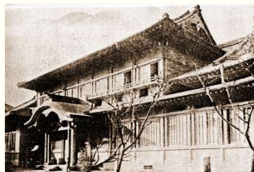
昭和13年改築された竹瓦温泉 (1938年)
