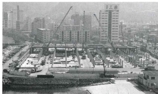
— ゆめタウン建設工事が進む楠港跡地 —
