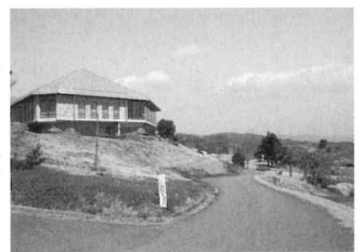
扇山ゴルフ場のクラブハウス
