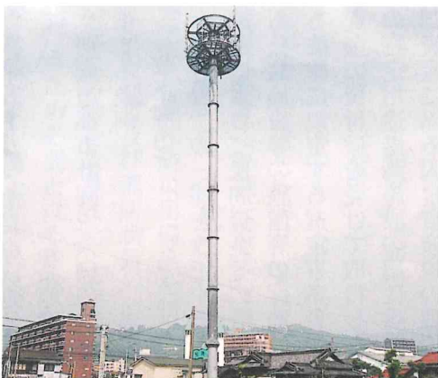
携帯電話の無線中継鉄塔
