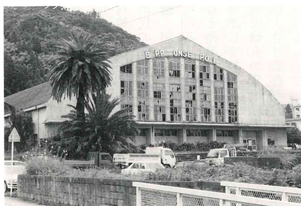
老朽化の著しい旧温泉プール（原町）
