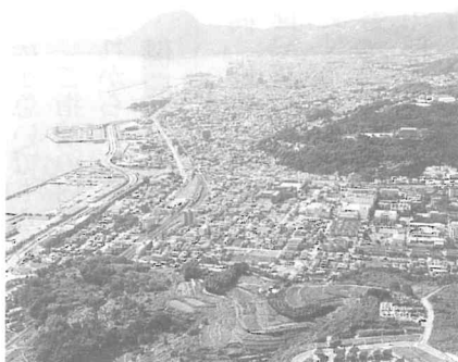
造成工事が遅れているリサーチヒル
