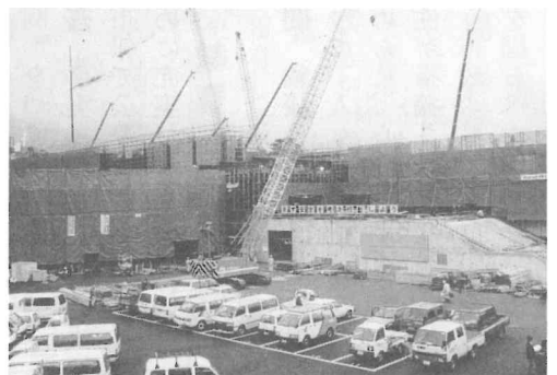
建設工事の進むBコンプラザ
