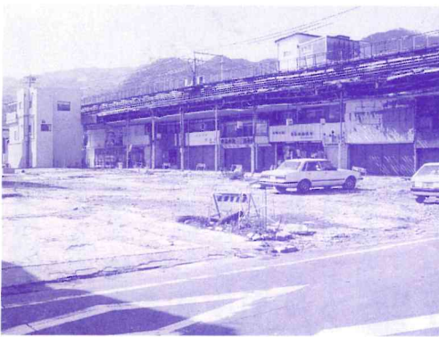
火災より1年余りが経過した松原被災地
