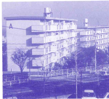
入居希望が絶えない市営住宅
