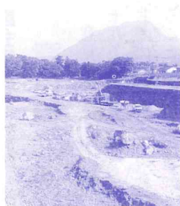
コンベンション センター工事現場
